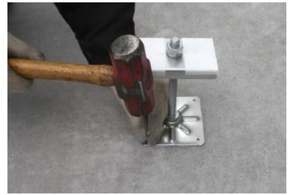
接着剤による浮き上がり防止・養生までの固定補助の為、コンクリート釘を任意の対角に2本打ちます。
