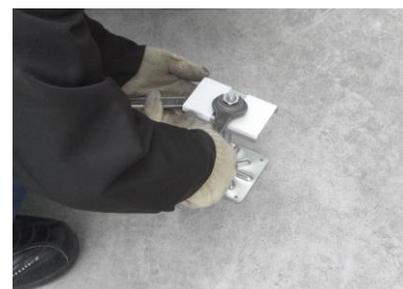
レベル出しが完了し、鋼製束の高さが決定すれば、六角ナットを本締めします。
