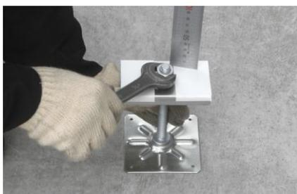
鋼製束を②の根太位置に仮置きし、鋼製束の高さを調整して、レベルを合せます。
