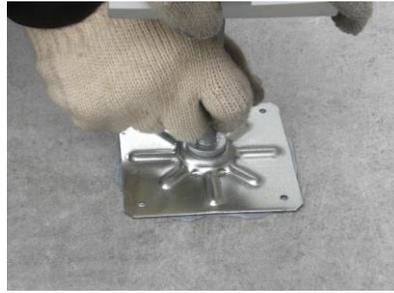
ベース面を床面にしっかり接地させ、接着剤が外周部から少しハミ出すくらいに広めになじむ様に押し付けて下さい。
