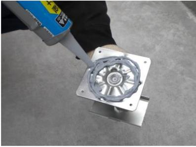
鋼製束のベースプレート裏面にボンド「エフレックス」を約20g塗布します。
