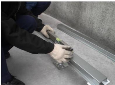
⑤で根太に罫書きした目印に合わせて、鋼製束に根太を仮置きします。
