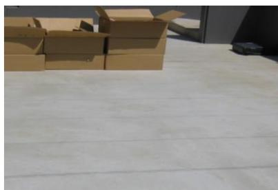
床面に根太位置の墨出し<sup>※1</sup>をします。
