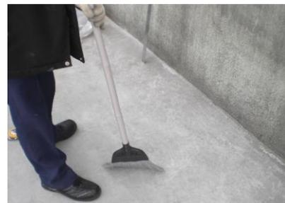
鋼製束を設置する床面の周囲をあらかじめ清掃し、ゴミ・ホコリ等を除去しておきます。
