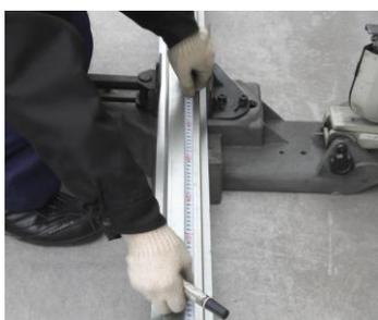
必要寸法を罫書き<sup>※2</sup>して根太を切断します。
